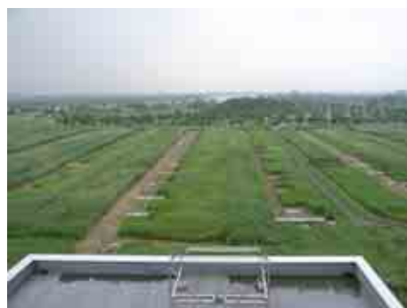
彩湖自然学習センターの屋上から見た浄化施設
