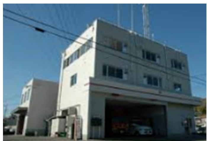
(西部分署庁舎)
