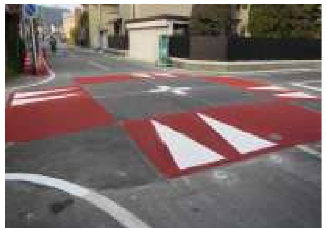
図4 - 19 物理的デバイス例(交差点ハンプ)
