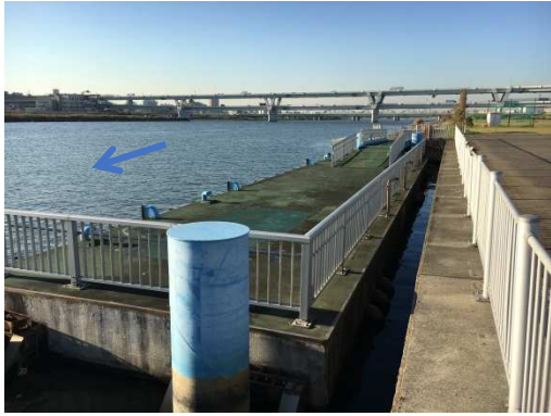
9. 堀切緊急用船着場
