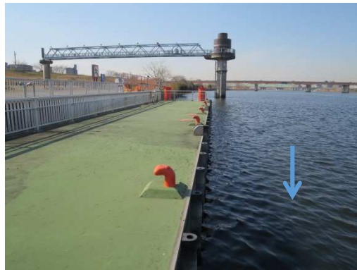
4. 岩淵緊急用船着場
