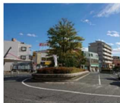
■戸田公園駅西口駅前
