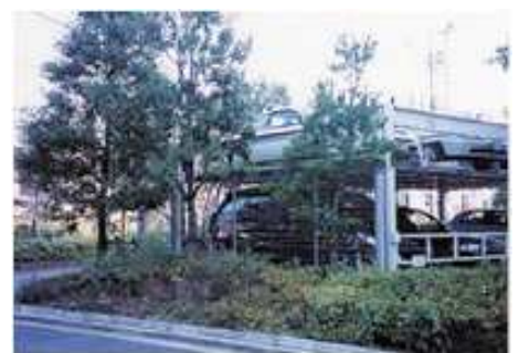
駐車場を緑で目立たなくし、周辺との調和を図っている例。
