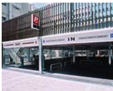
駐車場の道路側に格子を設置して外観を修景している例。
