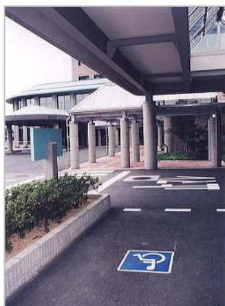
車いす使用者用駐車場から出入口まで屋根が設置されている例。
