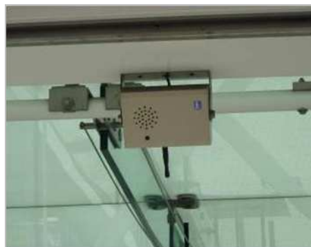
建物到着を知らせる出入口の音響案内スピーカーの例。
