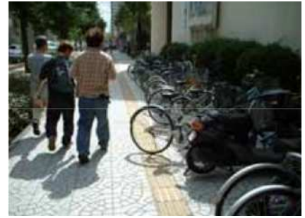
放置自転車が視覚障がい者誘導用ブロックの上に置かれ改善すべき例。
