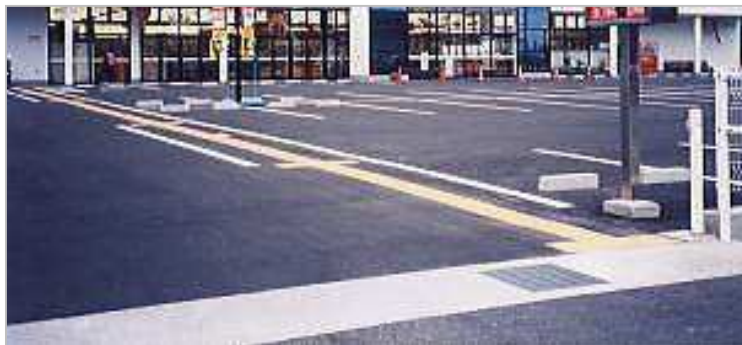
歩道から敷地入口、玄関部まで段差のない通路で、誘導ブロックが敷設されている例。
