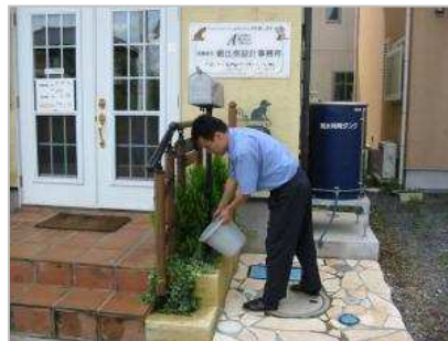
雨水貯水タンクを設置して草花の散水に利用している例。
