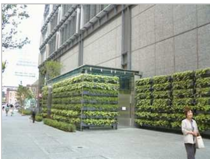
空調設備や管理者用地下階段室などが歩行者空間に面しているため、壁面緑化の工夫をしている例。
