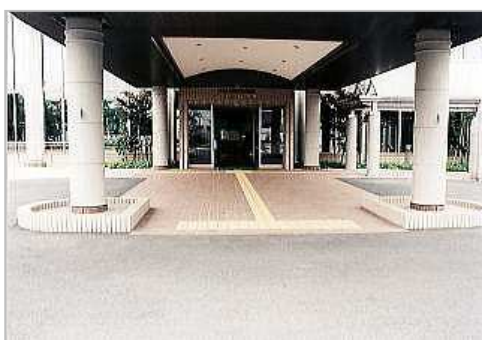
段差がなく、誰もが同じところを通して出入りができ、ひさしが長く、雨天時も濡れない玄関部の例。
