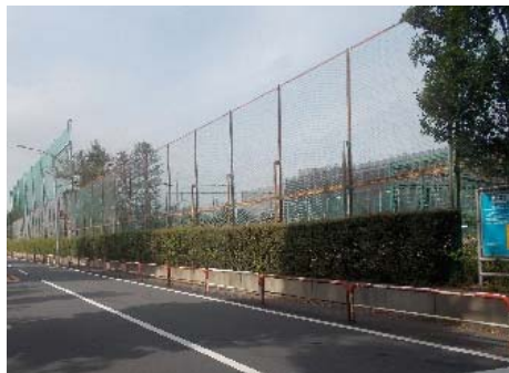
【笹目中学校前】 老朽化した防護柵の更新
