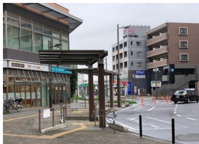
◎タクシー乗り場の段差がスロープにより解消されている
