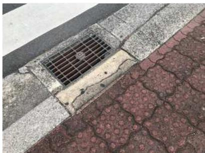
側溝蓋の穴が動線上にある
