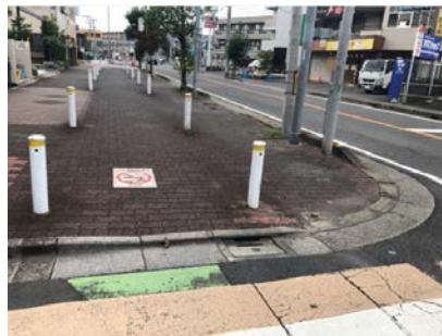
△歩車道境界の段差が大きい 誘導用ブロックがなく車止め に衝突するおそれがある
