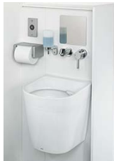
△便器備え付けの簡易型設備であり、オストメイト対応専用流し台※が設置されていない
