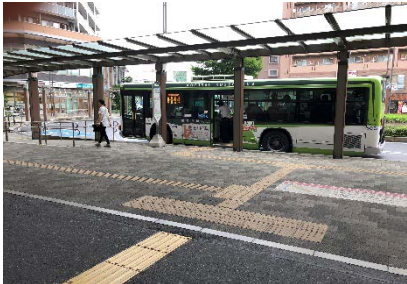
◎駅前交通広場に連続した屋根が整備されている
