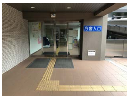
◎出入口への誘導用ブロックの設置や音声案内、自動ドアにより利用しやすい
