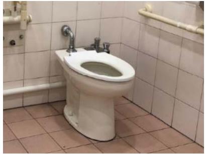
△便器備え付けの簡易型設備であり、オストメイト対応専用流し台※が設置されていない
