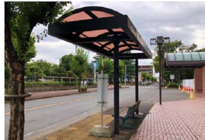
△バス停留所に誘導用ブロックが過剰に設置されている
