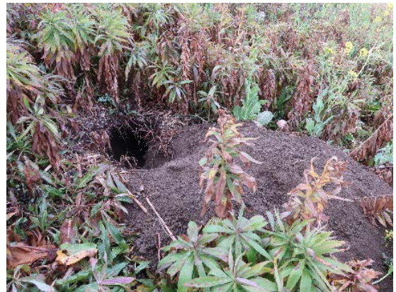
河川堤防に掘られた巣穴
