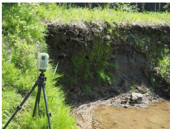
インターバルカメラの設置
