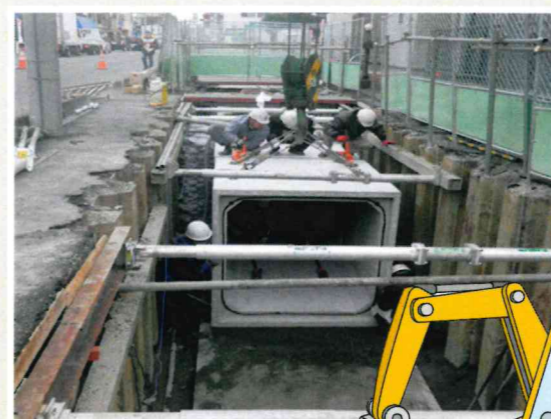
道路の下に管渠を布設します。
