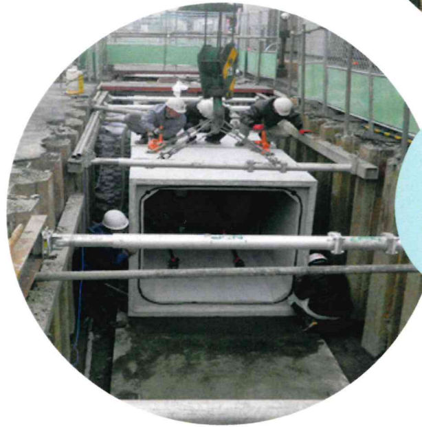
道路の下に管渠を布設します。
