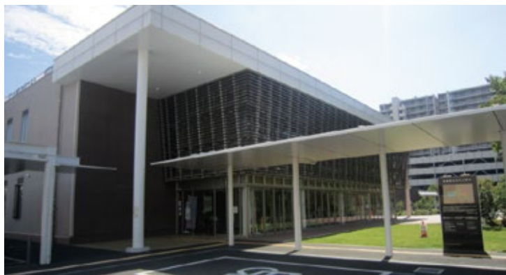
戸田市福祉保健センター 外観
