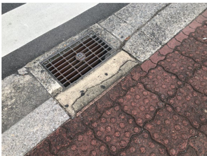
△側溝蓋の穴が動線上にある誘導用ブロックが舗装と同色でわかりにくい
