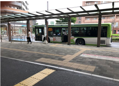
◎駅前交通広場に連続した屋根が整備されている
