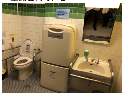
△空間が狭く、ベビーベッドなどで車いすで便器に近づきにくい
