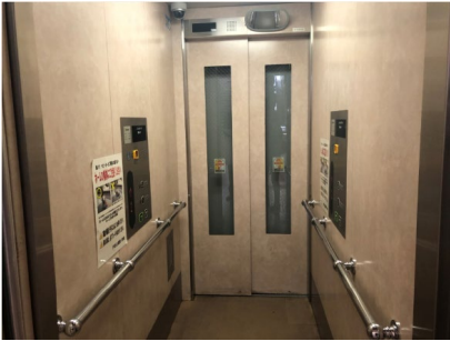
◎スルー式のエレベーターは車椅子使用者等が転回する必要がなく利用しやすい
