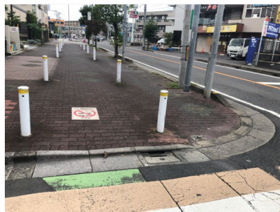
△歩車道境界の段差が大きい誘導用ブロックがなく車止め衝突のおそれがある
