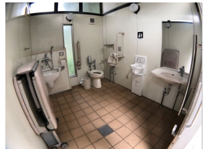
◎大型ベッドやオストメイト対応流し台が設置されている
