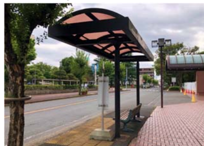
△バス停留所に誘導用ブロックが過多に設置されている
