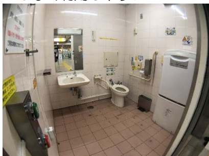
◎多機能トイレが車いすでも使いやすい大きさが確保されている
