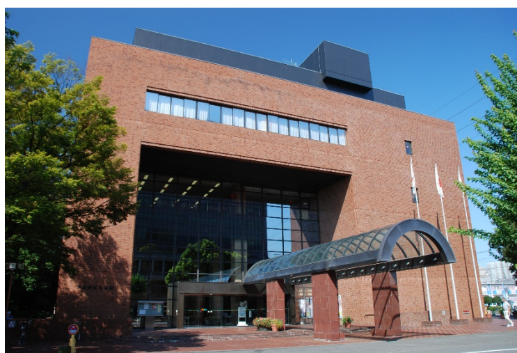
図 戸田市文化会館（改修工事前）
