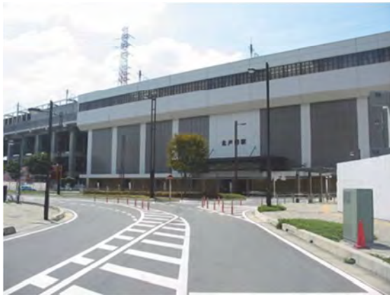
整備された北戸田駅東口駅前広場
