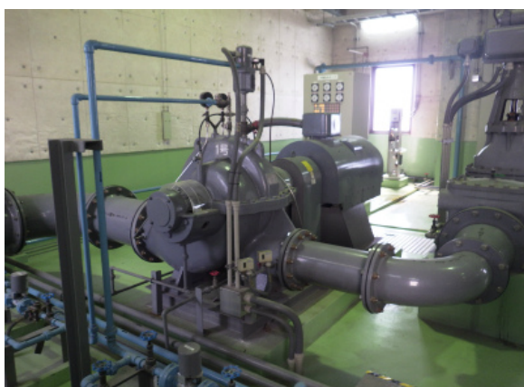
写真:東部浄水場配水ポンプ及び制御盤
