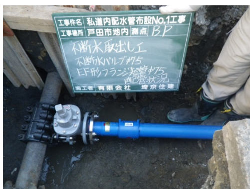
写真:私道内給水管整備状況(ポリエチレン管 口径 75mm)
