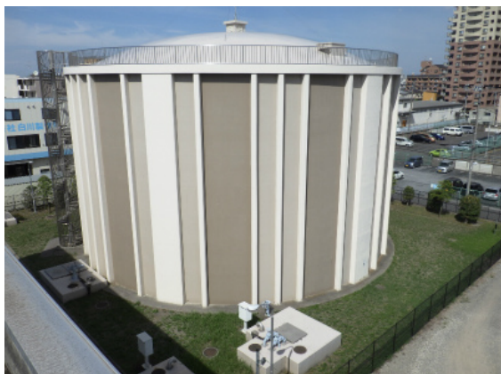
写真:東部浄水場配水池
