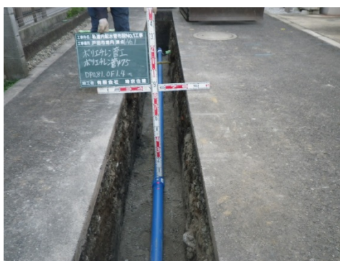
写真:私道内給水管整備状況(ポリエチレン管 口径 75mm)
