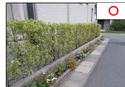
下部は低いブロック塀。上部は生垣に！
