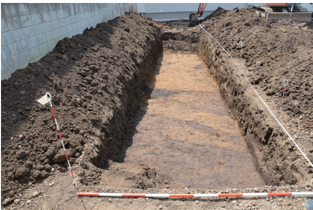
写真5 第1トレンチ完掘状況
