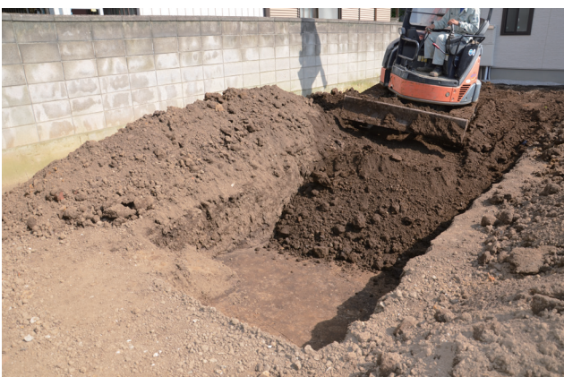
写真7 埋め戻し実施状況
