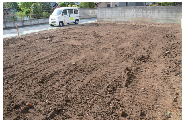
写真8 調査完了状況
