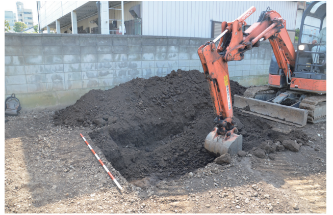
写真2 重機による掘削
